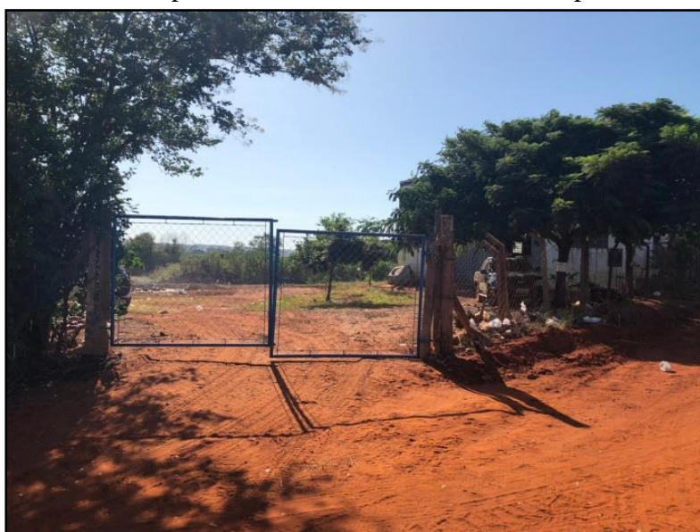
FIGURA3: ENTRADA DO ATERRO EM VALAS.
