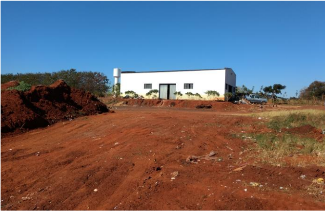
Foto 16 - Vista do Barracão na área do aterro.
