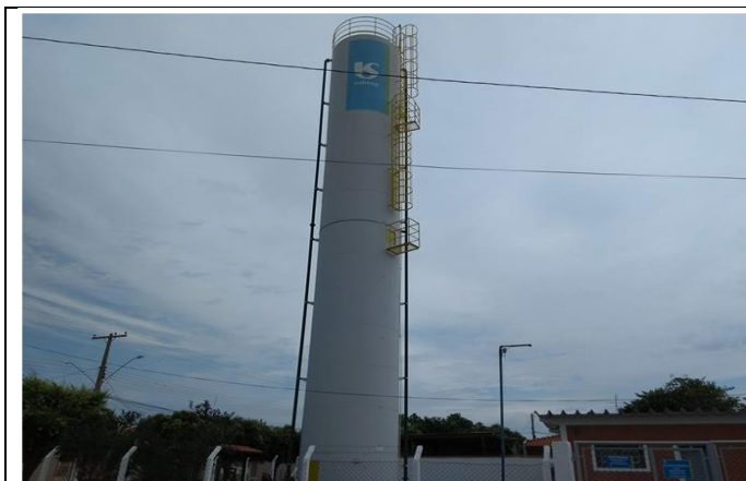
Foto 01 - Reservatório metálico elevado 70 m 3 .
